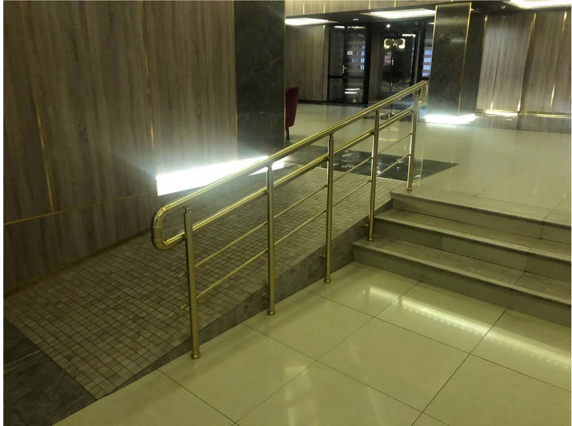
Приклади облаштування пандусів всередині будівлі в умовах незначних перепадів висот
