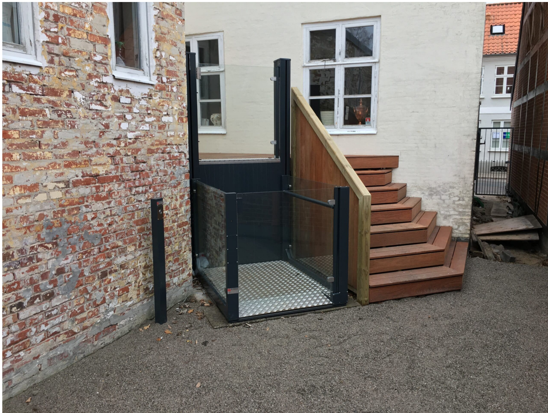
Приклади облаштування вертикального підйомника на прилеглий території
