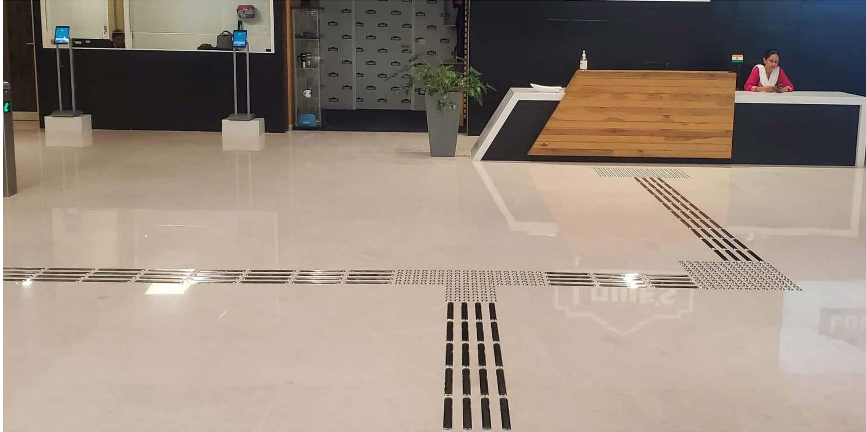
Приклад влаштування спеціальних тактильних смуг у лобі готелю
